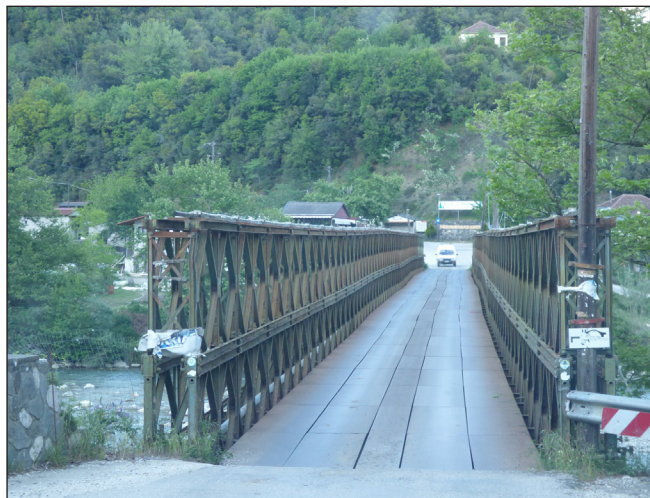
Στον «τόπο» της θα παραμείνει η γέφυρα στην Πλάκα
