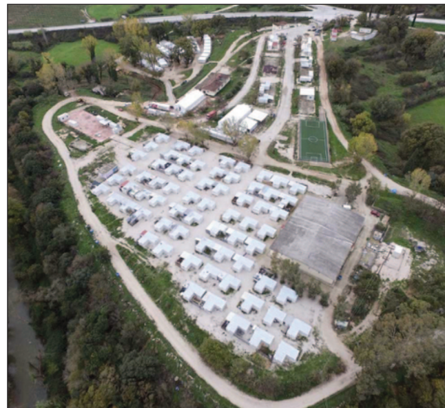
Κέντρο Υποδοχής Μεταναστών Φιλιππιάδας
